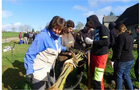
07.-09.04.2014 *Bündeln der Weiden um die Stahlkonstruktion*
